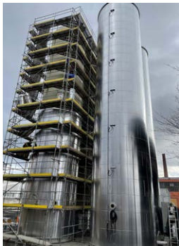
4 akumulční nádrže o velikosti 250 m 3
