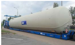
Instalace baterie 4 akumulčních nádrží o velikosti 4 x 250 m 3 ve Dvoře Králové
