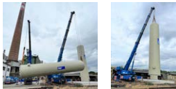
Instalace baterie 4 akumulčních nádrží o velikosti 4 x 250 m 3 ve Dvoře Králové
